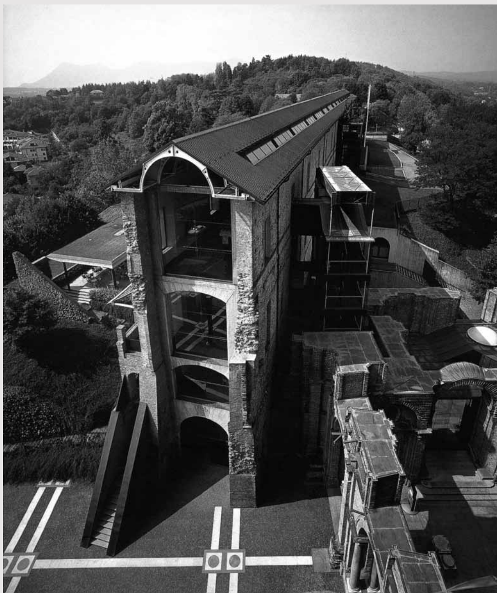
Façade est du château, observatoire sur le pignon ouest et vue depuis celui-ci sur la Manica Lunga.
