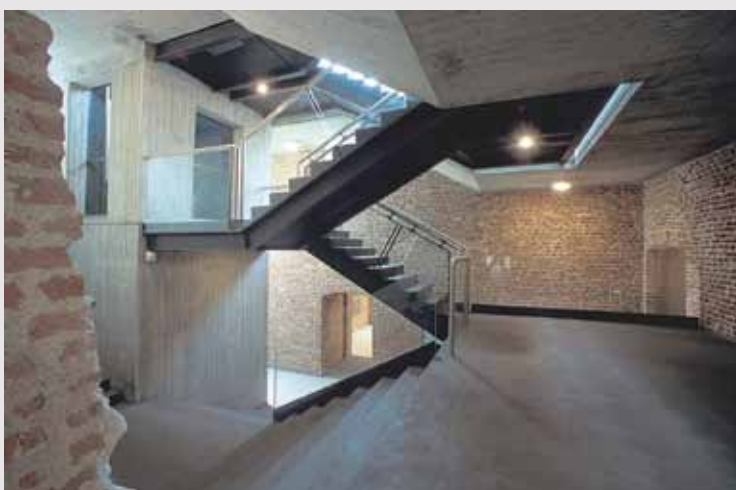
De haut en bas, passerelle au-dessus de l'extrados d'une voûte, vue d'une salle restaurée et escalier dans la Manica Lunga.
