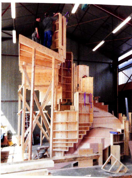
En haut à gauche, le coffrage de l'escalier hélicoïdal de l'Ackerhof réalisé en atelier puis démonté et réassemblé sur place. Le même coffrage a été utilisé pour créer les trois volées de l'escalier. En haut à droite, vues intérieures d'un escalier hélicoïdal dans l'Ackerhof. En bas, les nouveaux espaces d'exposition de l'Ackerhof avec leurs cimaises « flottantes ».
