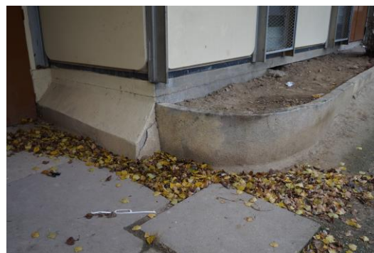
Photographies du soubassement béton, 2016 – Le vide du porte-à-faux a été comblé
