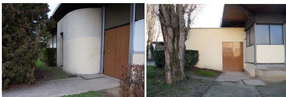
Volumes maçonnés en saillie des plans carrés : zone téléphone du Hall principal et lieu de stockage du Hall secondaire.
