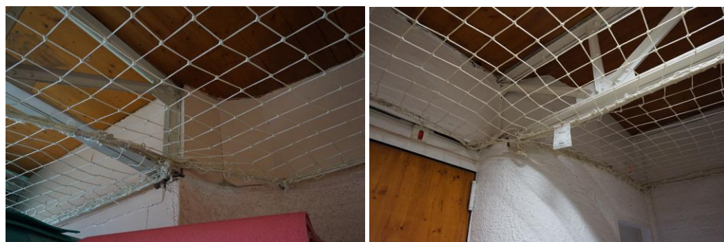
Les poutres treillis « coupées » en partie haute.
