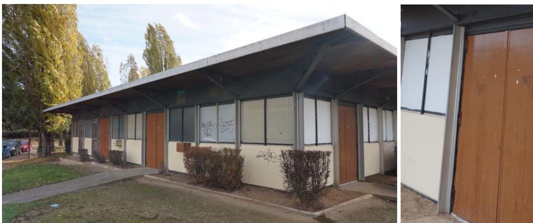
Configuration actuelle des façades et vantelles en verre, 2016. (Le grillage a été ajouté postérieurement à la construction du Hall).
