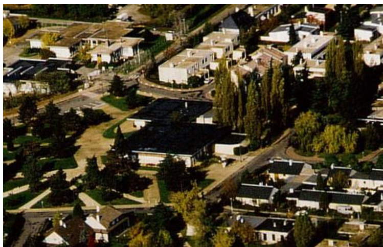
Vue aérienne du Hall du Villagexpo, milieu des années 1970. (Archives A. Poussin)
