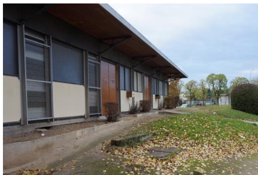
Photographies du soubassement béton, 2016 – Le vide du porte-à-faux a été comblé
