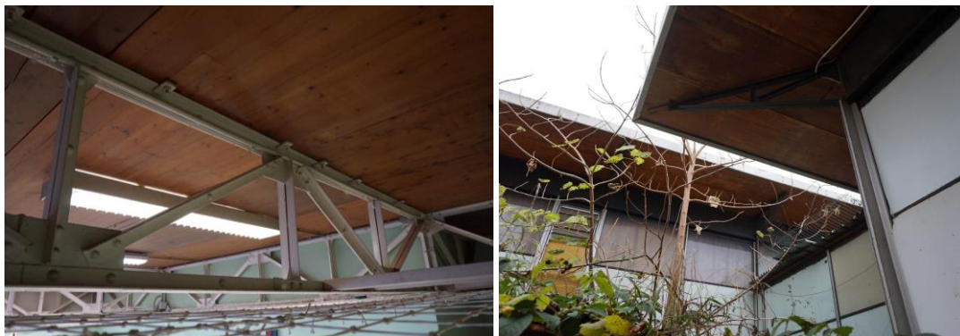
Plafond bois de l'ensemble du Hall d'exposition, 2016. La sous-face de l'auvent est également en bois apparent. 2016.
