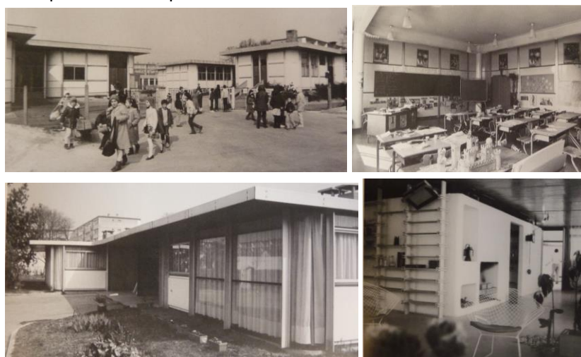
L'école Jules Verne et les logements d'instituteurs, 1966 (P. Sulzer)
