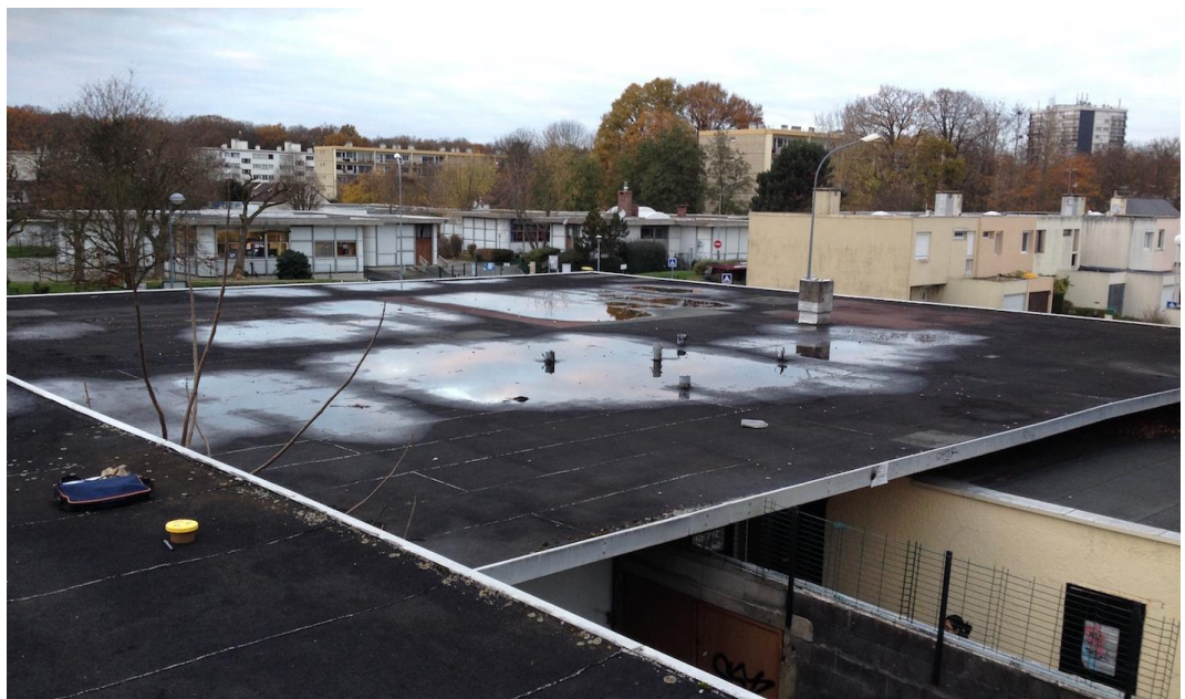
Couverture des Halls, 2016 (actuellement, revêtement en bitume)
