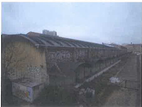
1. La Halle Freyssinet Vue de la passerelle de l'avenue de France Photo : Didier Rykner
