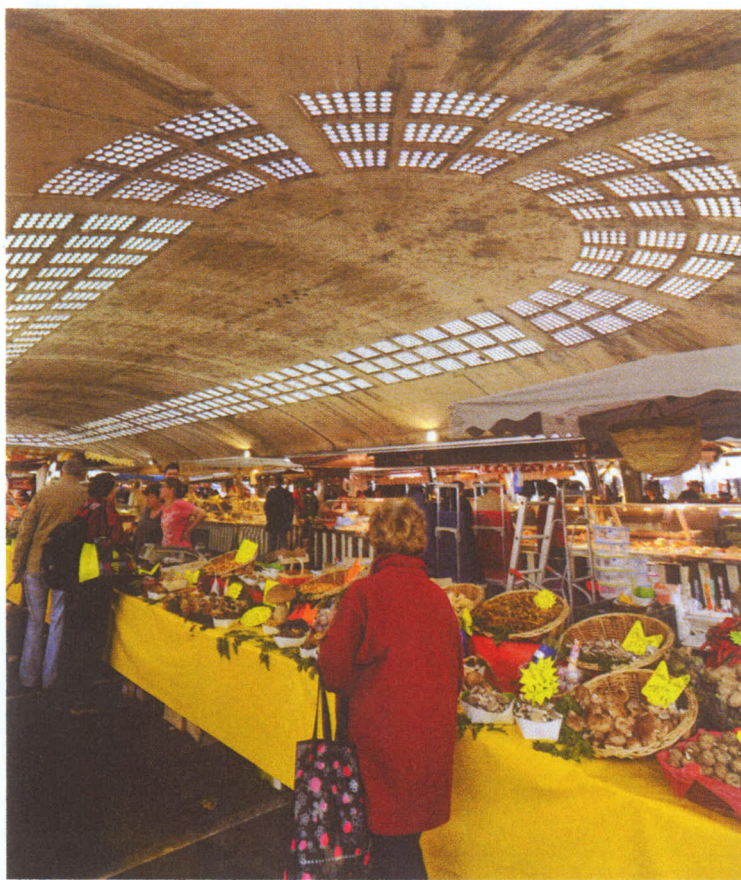
Inquiétude. La halle de béton du marché Saint-Louis sera démolie. La centaine de commerçants seront déplacés et craignent de perdre leur clientèle.
