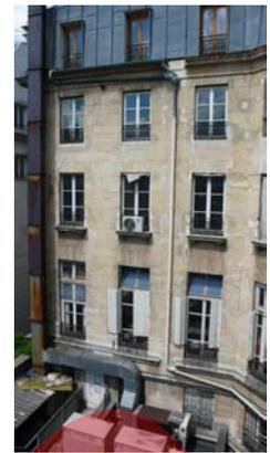
Dans les années 1960, on a tiré parti de la cour pour augmenter d'autant la surface utile des rez-de-chaussée. La couverture en terrasse qui règne avec le plancher haut de ce niveau est saturée d'engins techniques assurant notamment le conditionnement de l'air.
