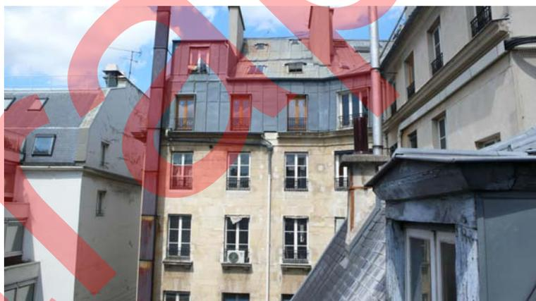
Le brisis du comble à la Mansart a été redressé à la verticale à une date indéterminée. Quelques menuiseries anciennes méritent d'être considérées. À défaut d'allège dont l'existence n'est pas attestée ou de garde-corps en fer forgé, des balustrades en fonte d'un modèle courant (début XX<sup>e</sup>) garantissent les fenêtres.
