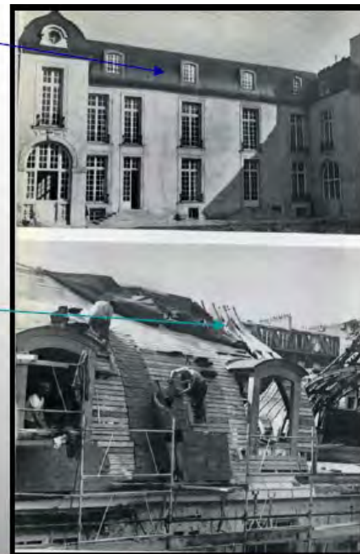
Fig.16 - Haut : charpente dite « à la Philibert Delorme », restaurée, vue côté jardin.
