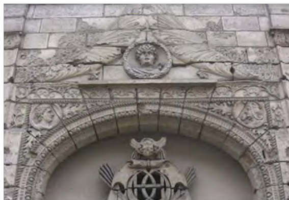
Fig. 12 : Vestiges de la porte d'entrée de l'hôtel située rue des Bourdonnais, dans la cour de l'Ecole des Beaux-Arts
