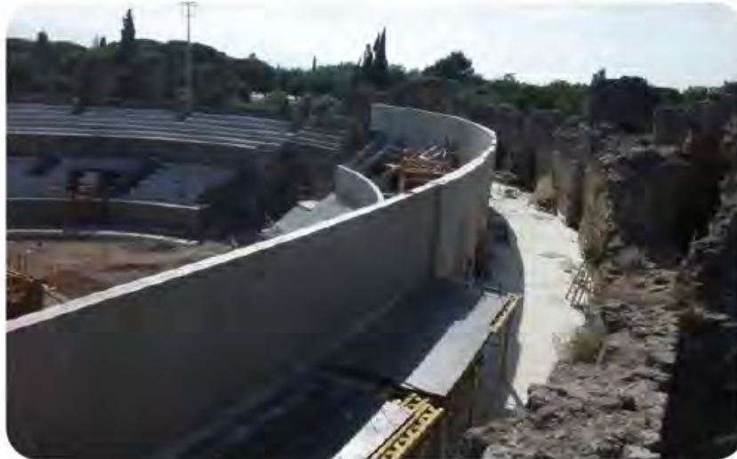
Mur de béton en construction
