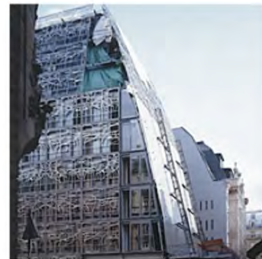
Façade du bâtiment d'Olivier Lahalle lors des travaux
