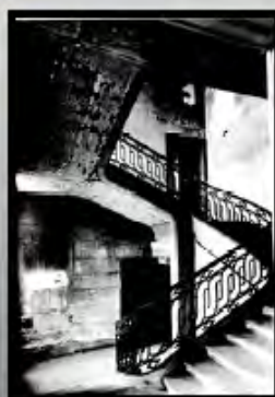
Fig. 10 -Escalier d'honneur, avant restauration. Fonds photographique Centre Culturel Suédois.
