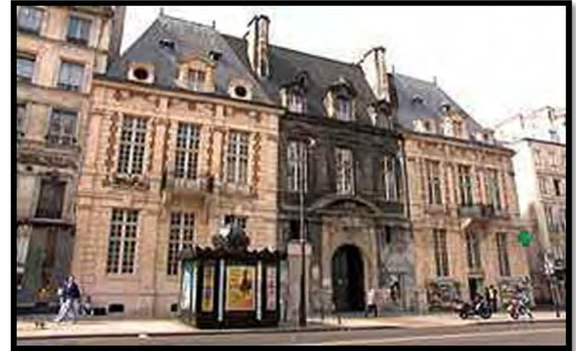
L'hôtel de Mayenne avant les travaux de démolition
