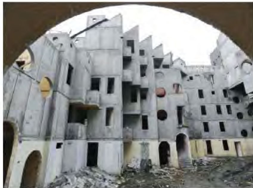
L'ensemble Desnos en cours de démolition
