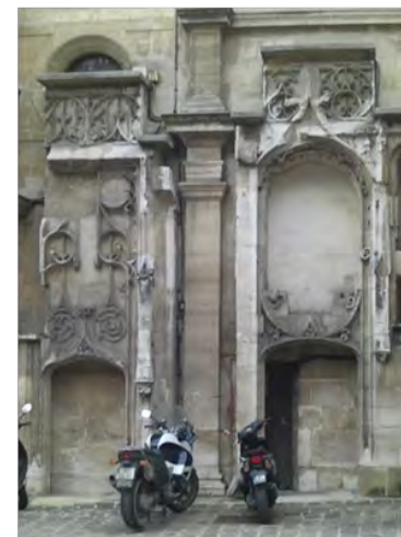
Fig. 14 : Vestiges de l'hôtel appliqués sur le mur nord de la cour de l'Ecole des Beaux-Arts
