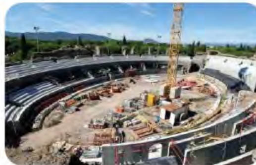
L'évolution du chantier en septembre 2010
