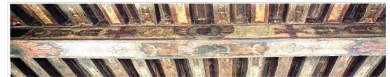
Chambre dite des Demoiselles, Dezeuze conserve le plafond d'origine à poutres et solives peintes
