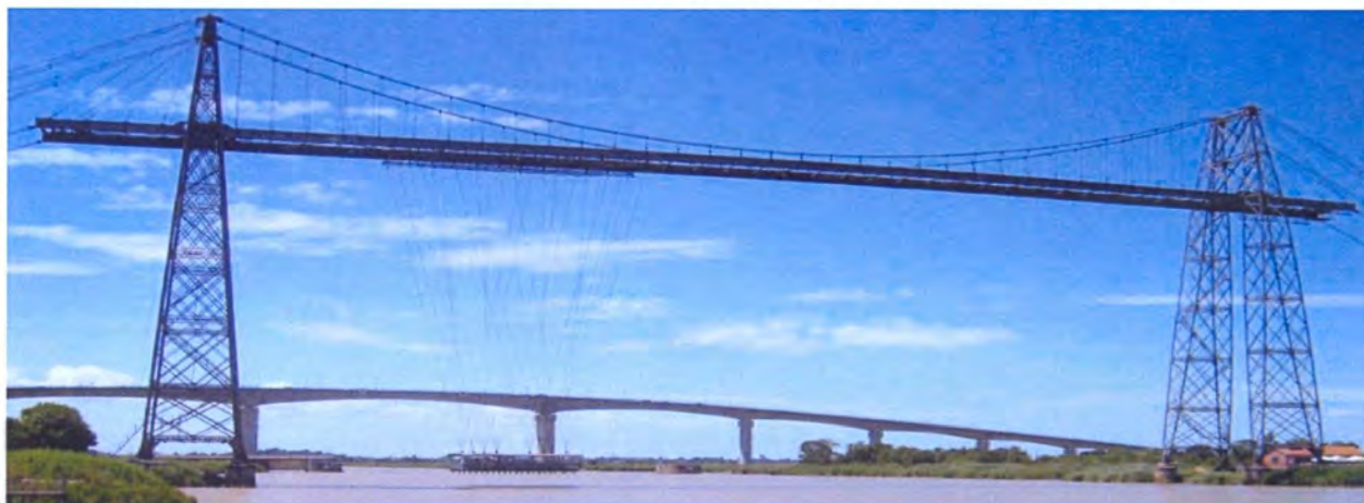
Vue du Pont et du Viaduc (décembre 2010)
