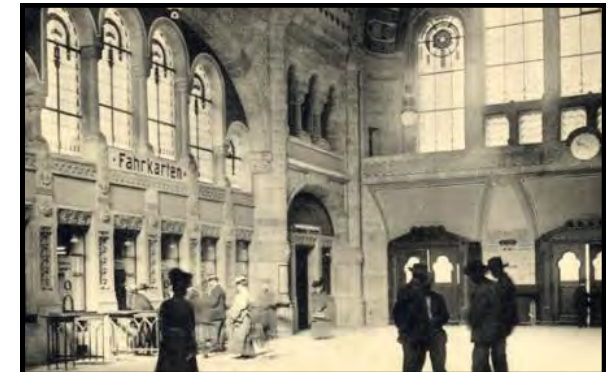
Fig.9: salle de l'entrée
