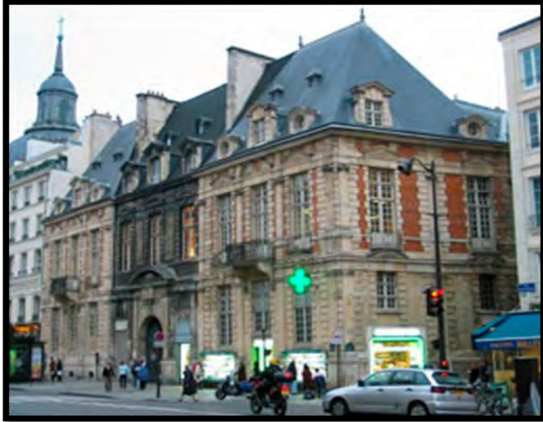
L'hôtel de Mayenne avant les travaux de démolition
