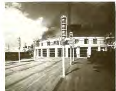
Doc 8 : infrastructures arrondies et vitrées sur le sundeck
