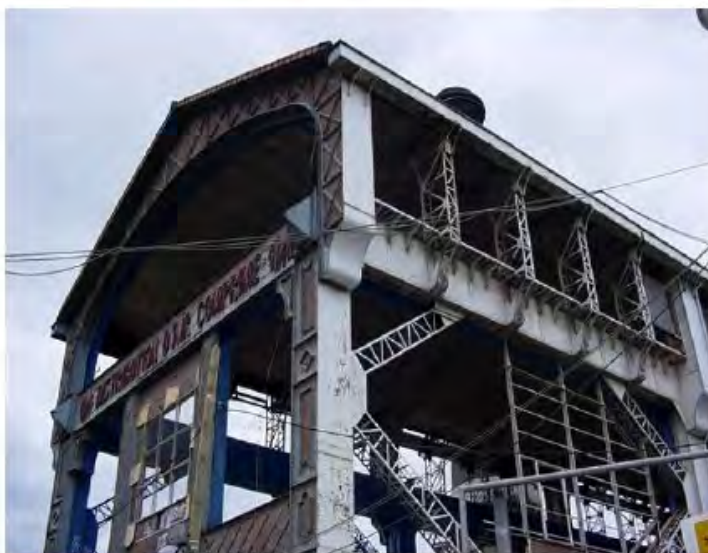
2002 : halle aux compresseurs, société urbaine d'air comprimé, photographie en début de chantier, prise de vue direct, dossier SUDAC, archive SEMAPA
