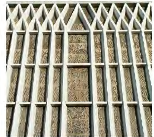
Doc 11 : Verre de protection externe et meneaux en béton
