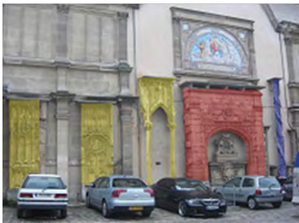
Fig. 13 : Vestiges de la tourelle (en jaune), de la porte (en rouge) et de l'escalier (en bleu) de l'hôtel sur le mur sud de la cour de l'Ecole des Beaux-Arts
