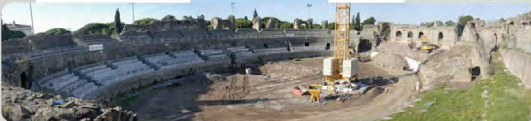
L'amphithéâtre au début des travaux de restauration
