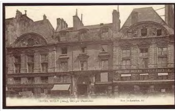
L'hôtel de Sully avant les travaux de démolition
