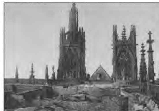
Fig. 10bis : Vue des combles après l'incendie.
