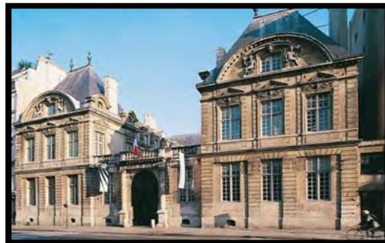
L'hôtel de Sully après les travaux de démolition
