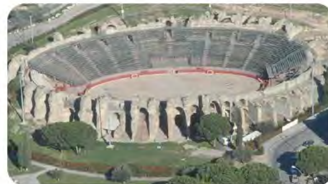
Vue aérienne de l'amphithéâtre avant la restauration
