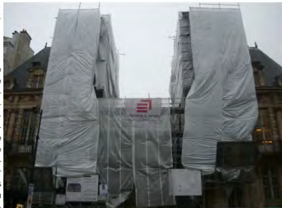
Aspect actuel de l'Hôtel de Mayenne en cours de restauration après le retrait du corps central du XIXème
