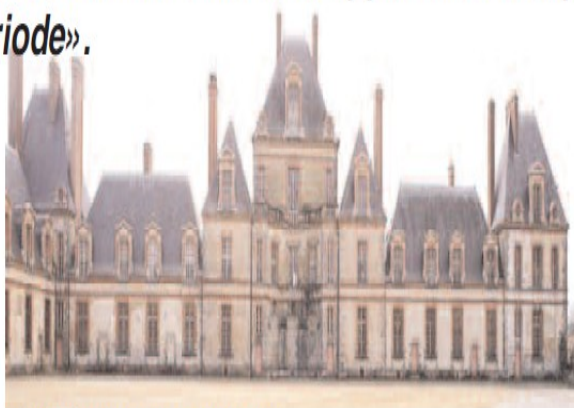
Intérieur de la Cour des Offices. Photo prise avant la restauration.
