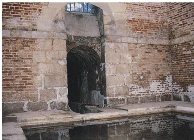
Le château d'eau. Photo contemporaine.
