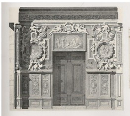
10. Les extrémités de la galerie François I er , relevés de Rodolphe Efnor. 1963
