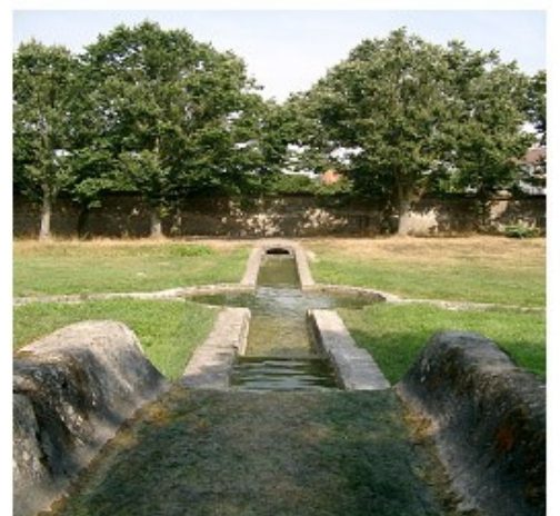
L'exutoire à la fin du grand canal au bout du parc
