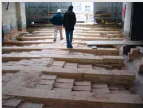
Le principe des terrasses est de distinguer le sol qu'on foule et l'étanchéité de la couverture appelée à disparaître dans les épaisseurs construites. Inédite en France, cette réalisation témoigne de l'impact durable des conceptions de Léonard sur la construction de Chambord.
