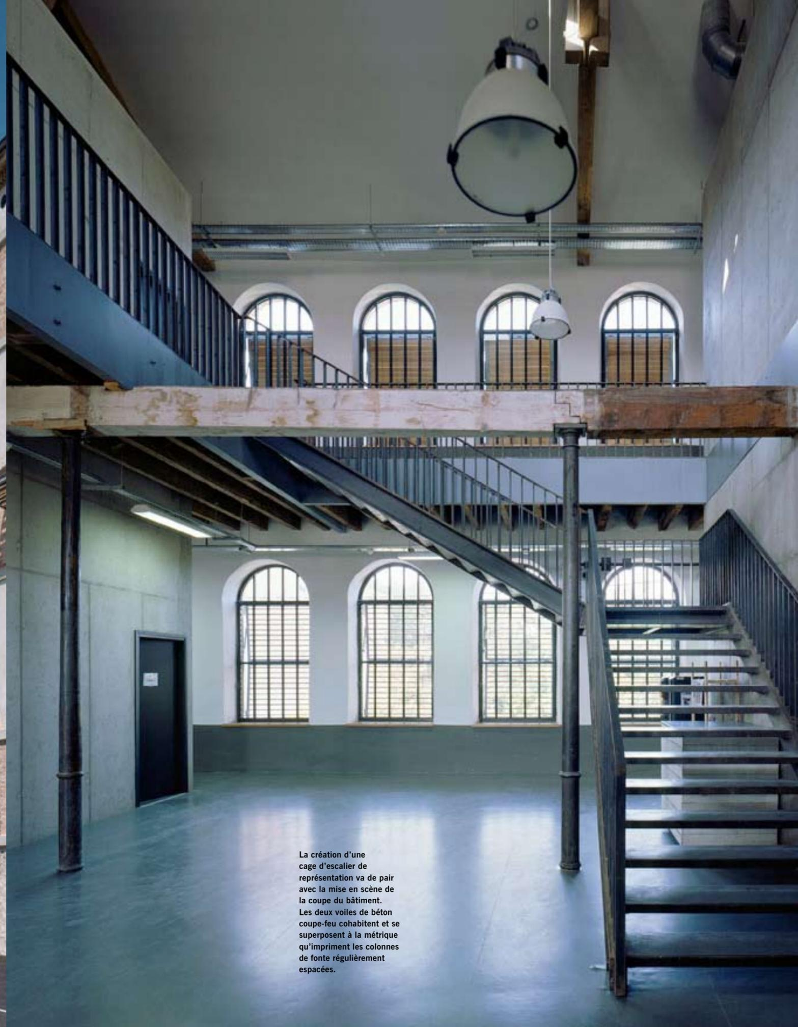
La création d'une cage d'escalier de représentation va de pair avec la mise en scène de la coupe du bâtiment. Les deux voiles de béton coupe-feu cohabitent et se superposent à la métrique qu'impriment les colonnes de fonte régulièrement espacées.
