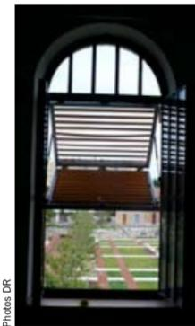
Escamotables et équipées de lames orientables, les persiennes permettent de doser utilement la lumière dans un édifice criblé de fenêtres. Elles participent d'une texturation changeante des élévations restaurées.
