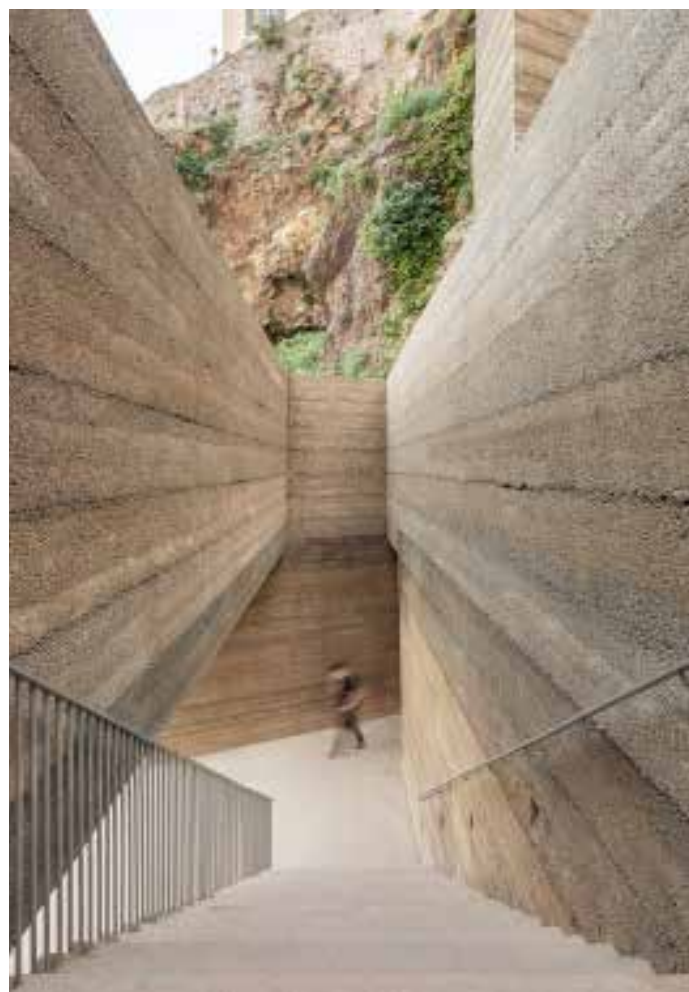
Ci-dessus : l'ascension piétonne à la citadelle s'effectue grâce à une série d'ouvrages conçus en béton de site, dont certains consistent en des diaphragmes horizontaux.
