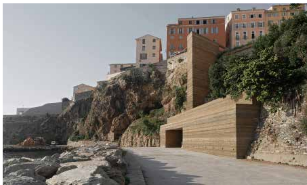
Ci-dessus : l'ascension piétonne à la citadelle s'effectue grâce à une série d'ouvrages conçus en béton de site, dont certains consistent en des diaphragmes horizontaux.
