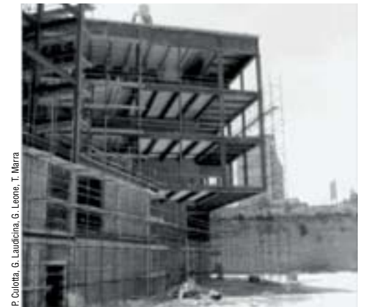
Le bâtiment en cours de chantier dévoile sa structure métallique.
