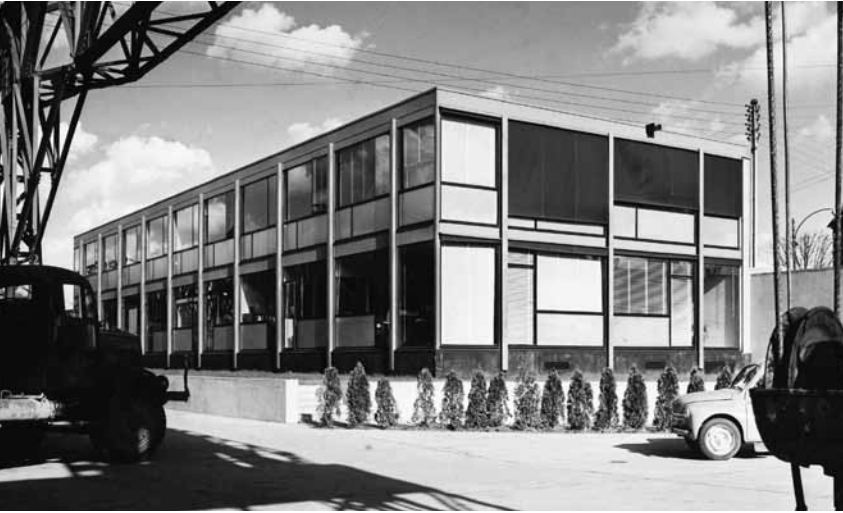
SIÈGE DE LA SOCIÉTÉ MARCHAND, À IVRY-SUR-SEINE (1961). La densité du bâtiment de métal et de verre réalisé en filière sèche permet d'optimiser le prospect avec les entrepôts.
