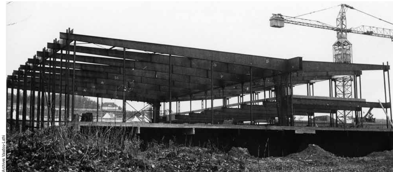
Le chantier de la piscine. Capotages et vitrages toute hauteur feront valoir l'équilibre de la structure porteuse asymétrique.
