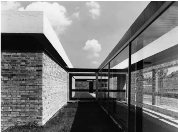
Une galerie vitrée au dessin minimaliste relie les vestiaires aux bassins. En transparence, le logement du gardien.
