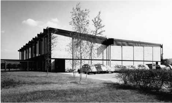
Côté avenue d'Essômes, la piscine présente un pignon aveugle, garant de l'intimité mais aussi du contreventement.
