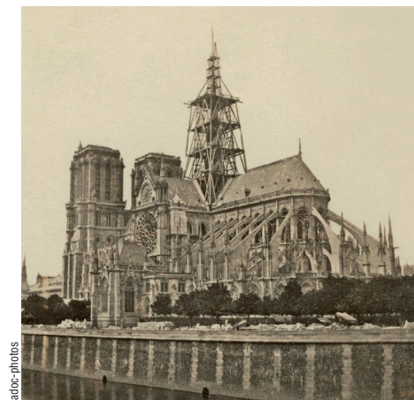
Reconstruction de la flèche et sobriété de l'échafaudage (1863).
