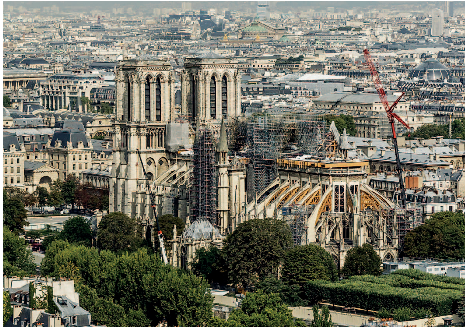
La cathédrale, en septembre 2019. Les travaux de consolidation des arcs-boutants sont visibles.
