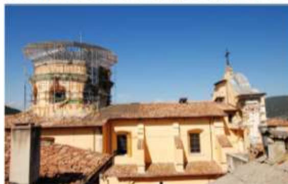
3. Vue de l'église, après l'intervention d'ingénieurs spécialisés. Photo : Mibac
