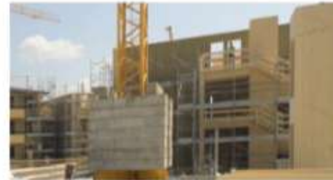
Bâtiment préfabrique en bois
