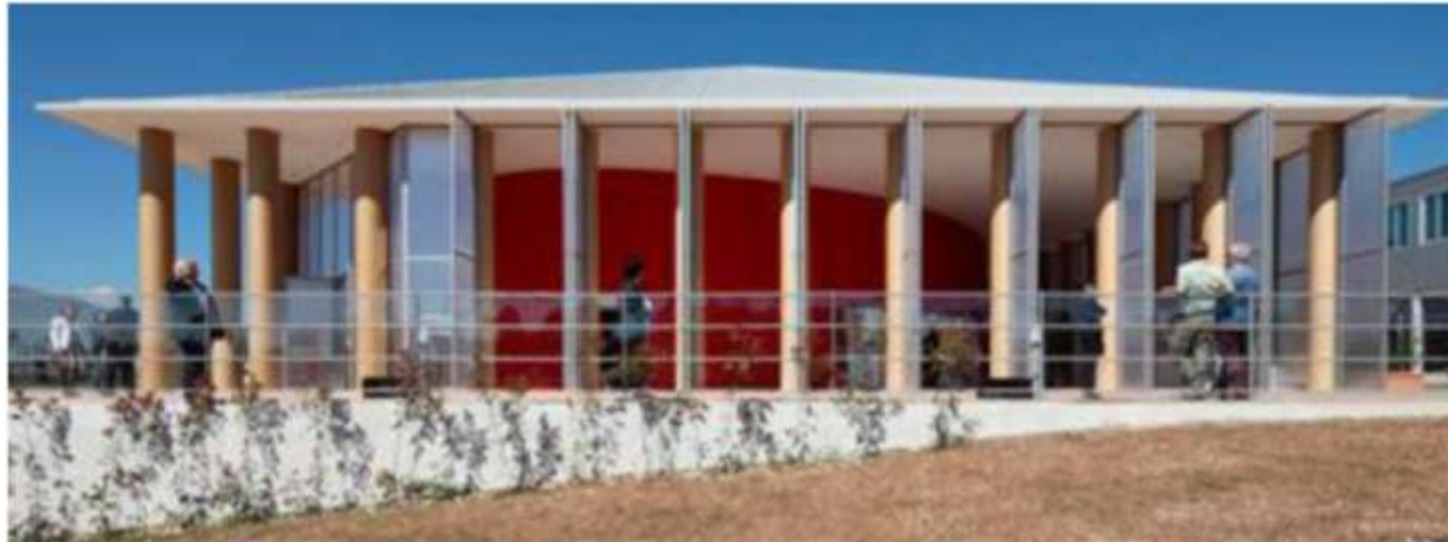
Doc. 5: parois amovibles en polycarbonate de la façade est © ShigeruBanArchitects
