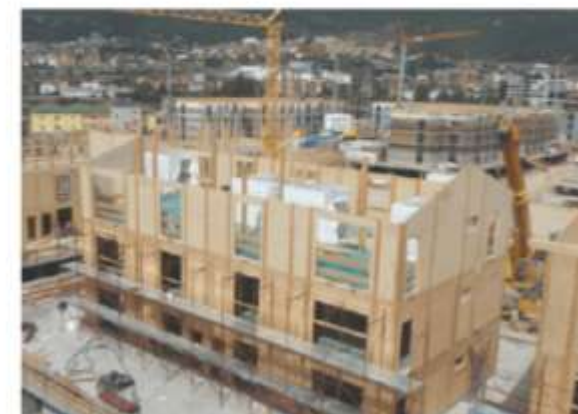
Chantier : panneau de bois contre collé BBS.
