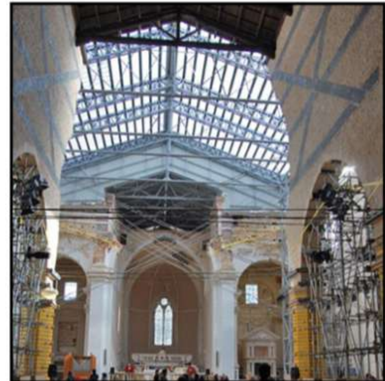
Doc 10: Consolidation de la nef et de la croisée du transept
