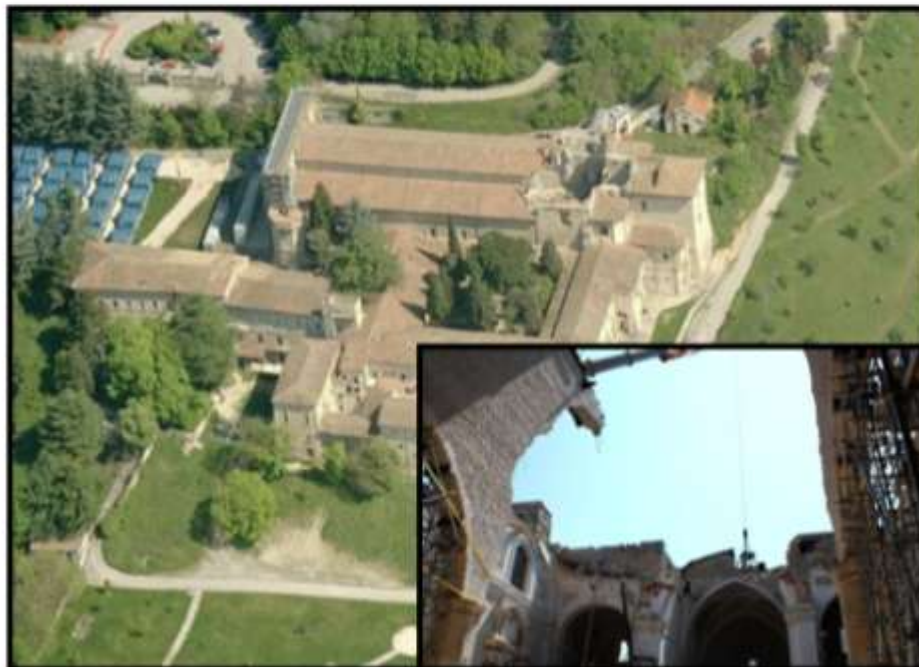
Doc 9: Dégâts vus au niveau de la nef et du transept
