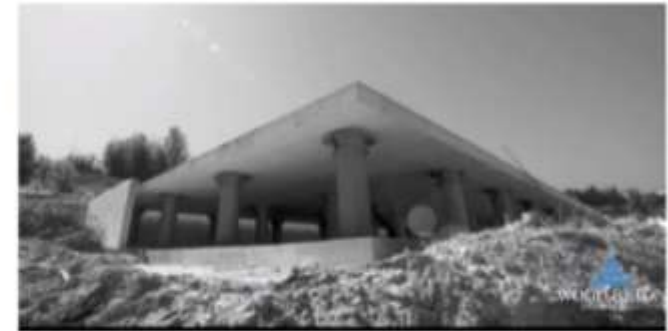
Photo isolation sismique des nouveaux bâtiments construits quelques mois après le tremblement de terre de L'Aquila
