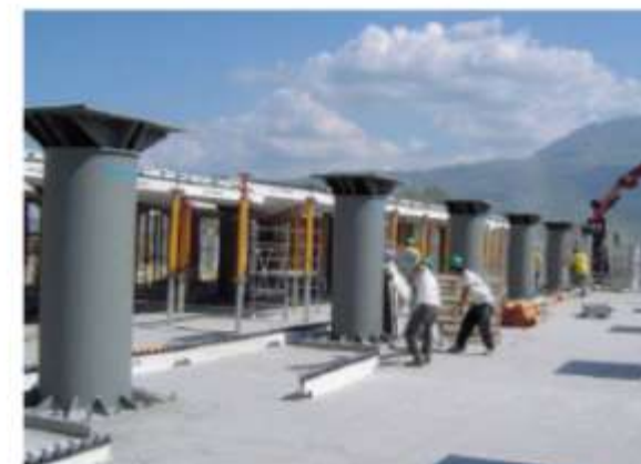
Chantier, mise en place de la structure antisismique.
