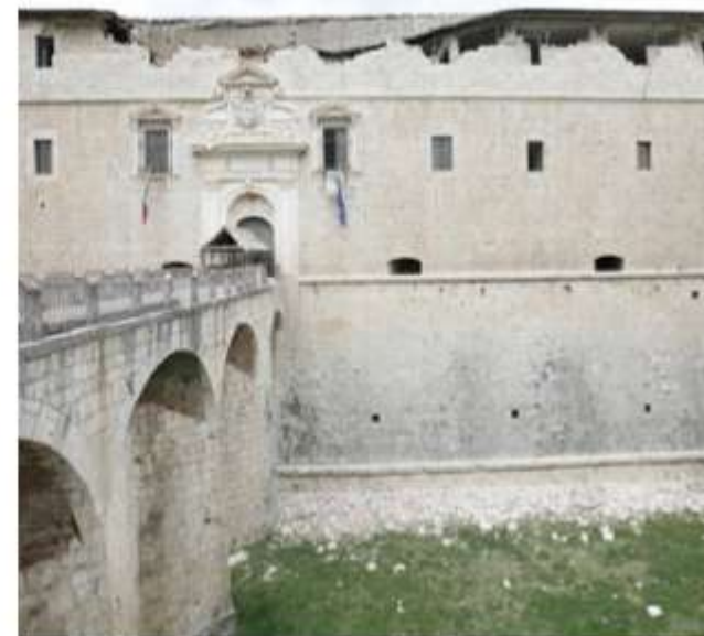
Les dégâts extérieurs du fort, façade Sud-Est
