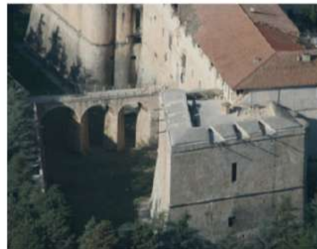
Vue aérienne du bastion Est
