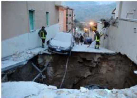
Photo de l'effondrement d'une rue
