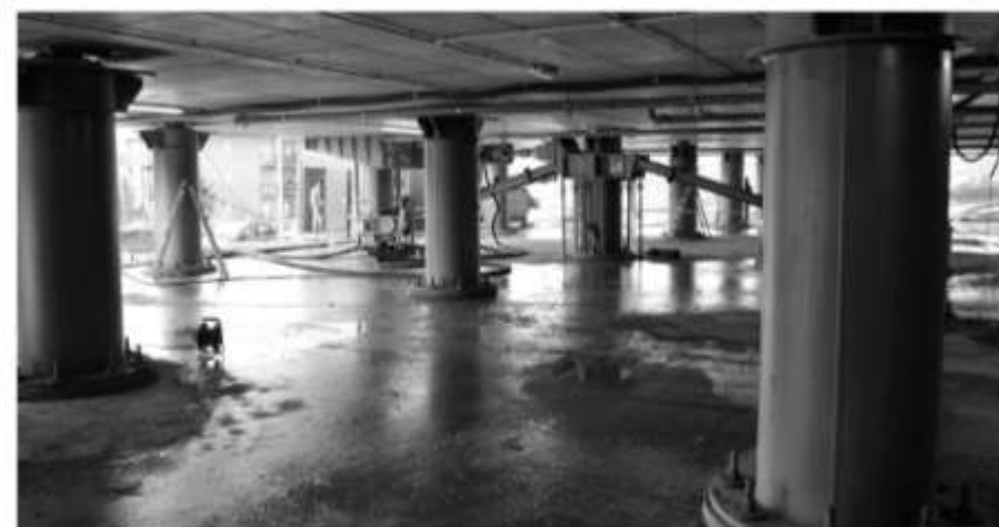
Vu d'un des bâtiments construits et de son sous sol.(plaque antisismique servant aussi de parking).
