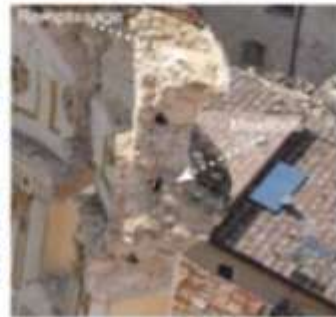
Mur vertical - construit en moellons et maçonnerie de remplissage - les reins de la coupole ont une continuité avec les nervures ? - les radisseurs descendent-ils jusqu'au niveau d'assise de la coupole ?
