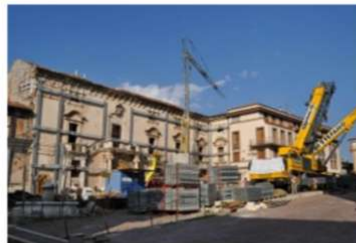
Travaux de restauration
