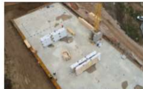
Plancher en béton armé
