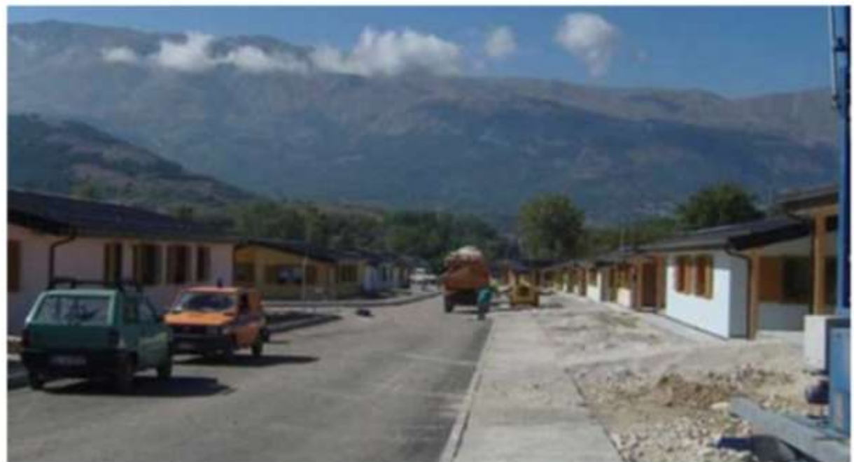
Village provisoire avec chalets en bois à Onna
